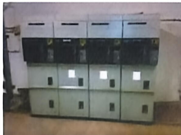
Gambar 2.8 Panel utama tegangan menengah
