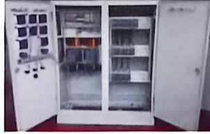
Gambar 2.9 Panel Utama Tegangan Rendah
