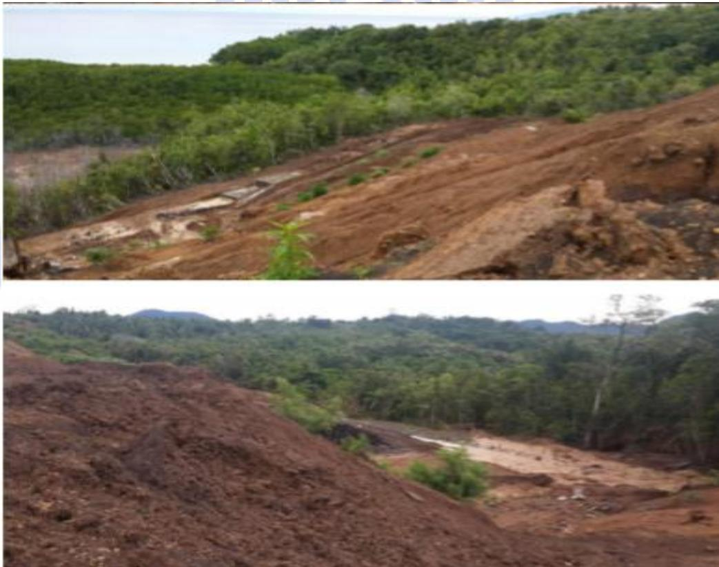
Gambar 1.2 Kondisi lereng yang sudah di timbun tanpa perkuatan
