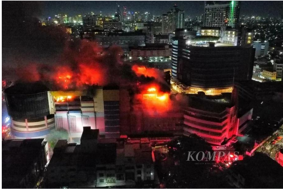
Gambar 1. 1 Foto Udara Kebakaran di Glodok Plaza-Jakarta https://www.kompas.id/artikel/glodok-plaza-terbakar-diduga-9-pengunjung-sempat-terjebak
